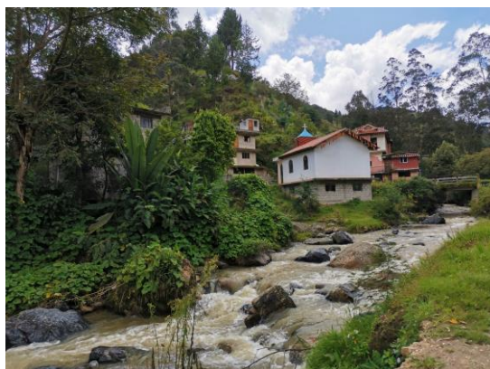
FOTOGRAFÍA 33. INFRAESTRUCTURA ANTROPOGÉNICA ELEVADA EN LA COMUNIDAD DE PALO BLANCO AL MARGEN DEL RÍO CON ALTA VULNERABILIDAD ANTE EL RIESGO DE INUNDACIÓN.
