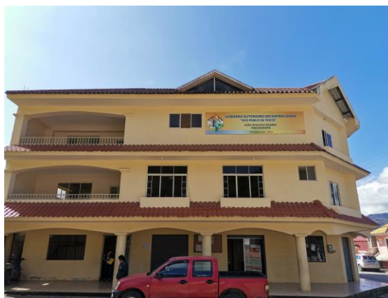
FOTOGRAFÍA 15. INSTALACIONES DEL GOBIERNO AUTÓNOMO DESCENTRALIZADO.
